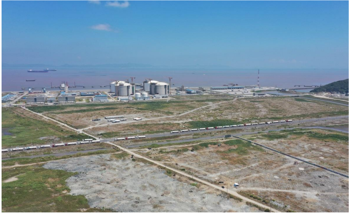
图 3-6 项目东侧 LNG 码头及取排水口现状
